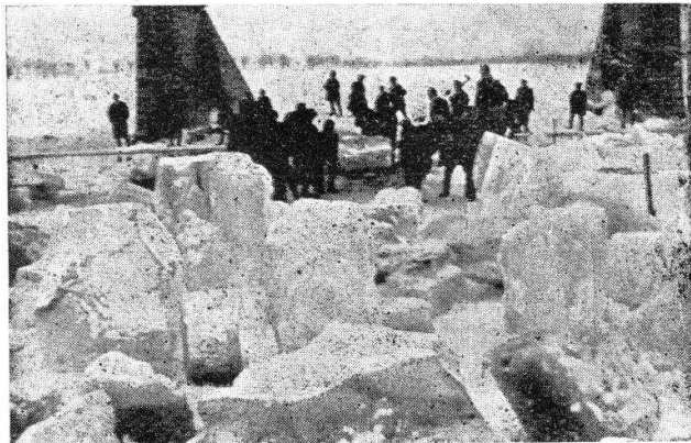
Ulanów nad Sanem. — Uwalnianie mostu od lodów.
