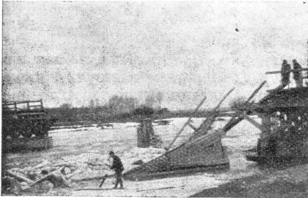
Ulanów nad Sanem. — Most na Sanie po zerwaniu.
