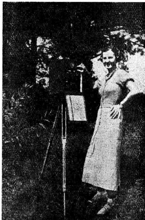
Ryc. 5. Transceiver z pionową anteną dla pasa 430 mc przy pracy w terenie. Przy aparacie PL343.
